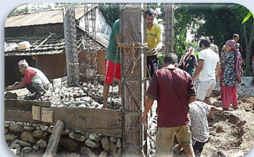
Opbouw voor tanks en zonnepanelen in Jutpani.
